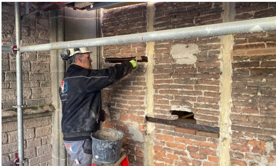
Beurtelings worden de originele brugijzers tegen roest behandeld en weer weggemetseld
