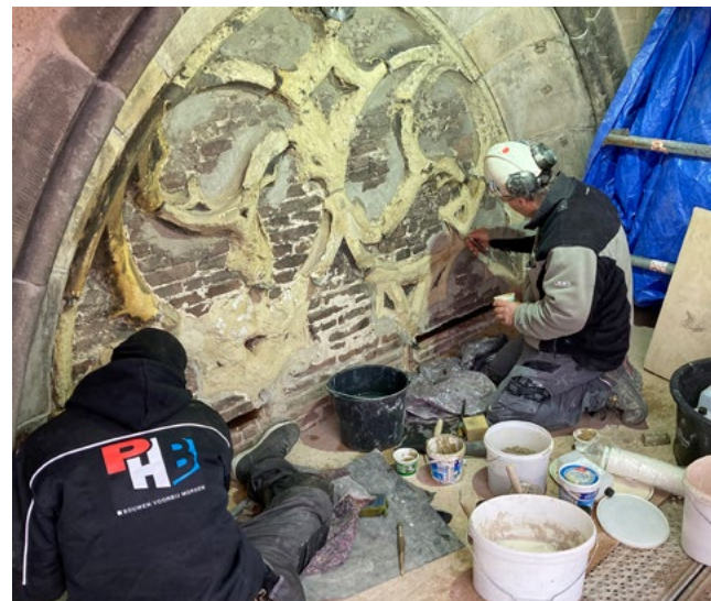
Ingenieus verstevigen en herstellen de vlakke de verweerde venstertraceringen
