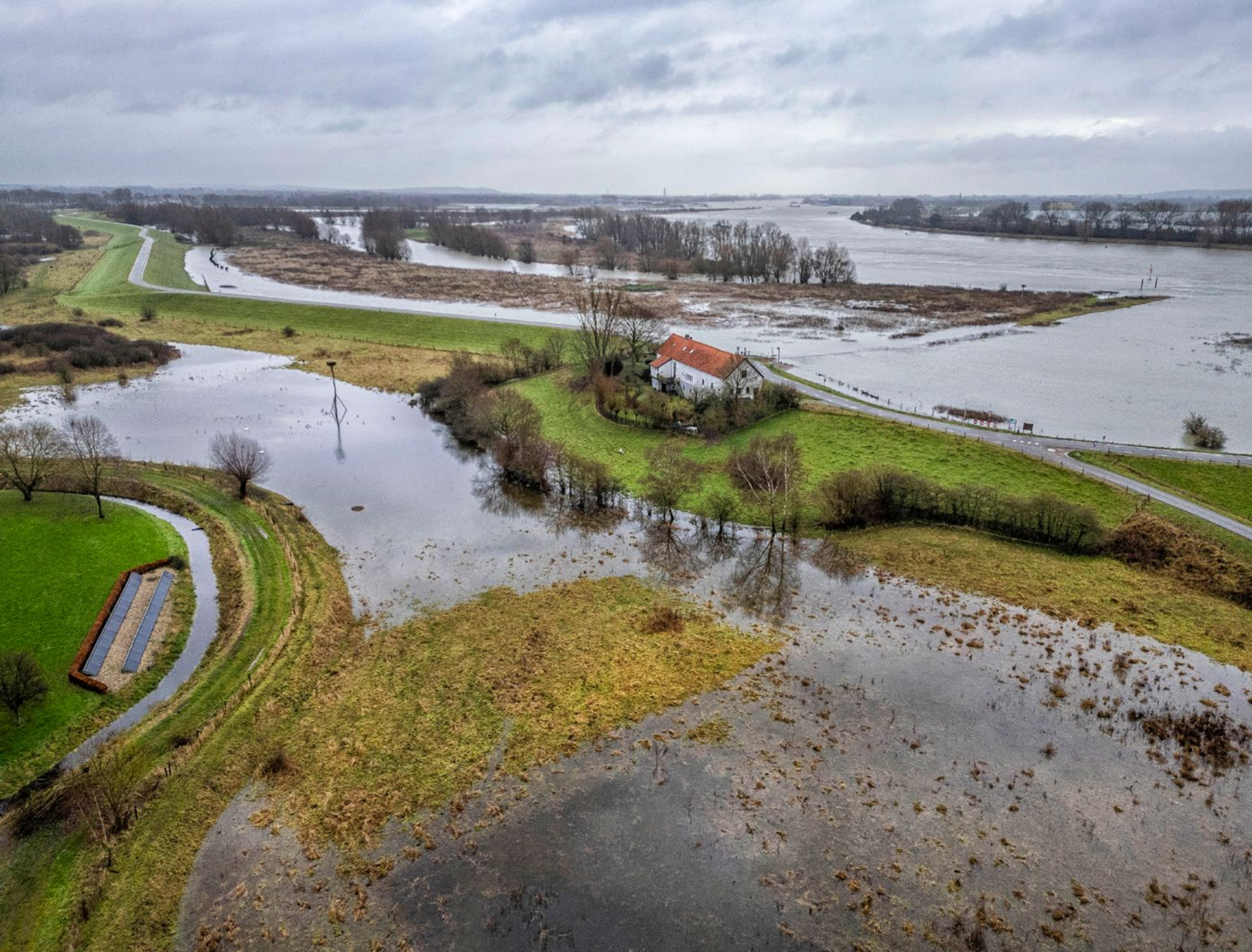
Bij de hoge stand van de Waal in december 2023 houden de historische kwelkades achter de dijk bij Doornenburg als vanouds het water tegen dat hier onderdoor sijpelt
