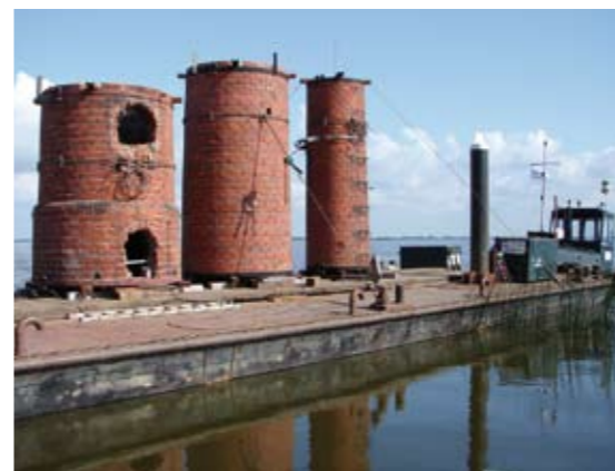
Deze gedemonteerde fabrieksschoorsteen, in Sneek gebouwd in 1929, wordt herplaatst bij het Gemaal van Echten
