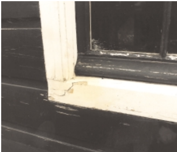
Het loskomen van een kunststof reparatiemortel (foto Theo Smit)
