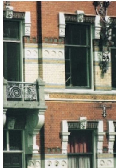
Den Haag, Statenlaan. Voorbeeld van een monumentale gevel waarbij de keuze van de reinigingstechniek(en) moet worden afgestemd op de diverse gevelmaterialen
