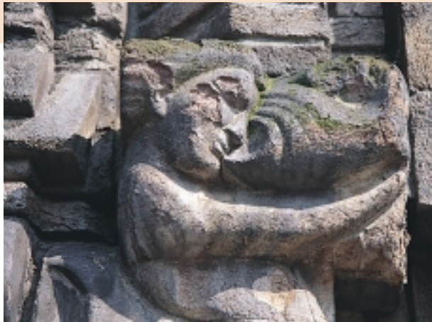
Amsterdam, een detail van het Scheepvaarthuis. Het behoud van het onderliggende materiaal stelde grenzen aan de mate van reiniging
