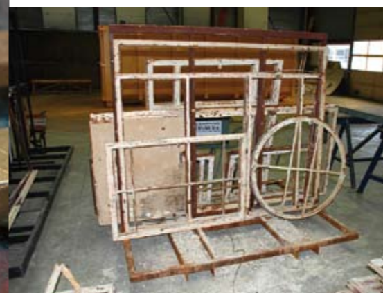
Stalen ramen en deuren in alle soorten en maten, klaar om gestraald te worden, waarna een beeld kan worden verkregen van de werkelijke schade
