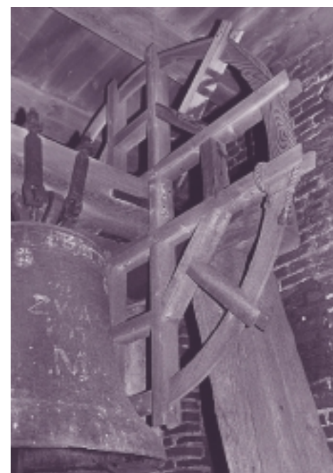
Luidklok aan rechte luidbalk met houten luidwiel in de Hervormde kerk te Zwaag. De klok dateert uit 1448 (foto collectie V. Nieuwenhoven)
